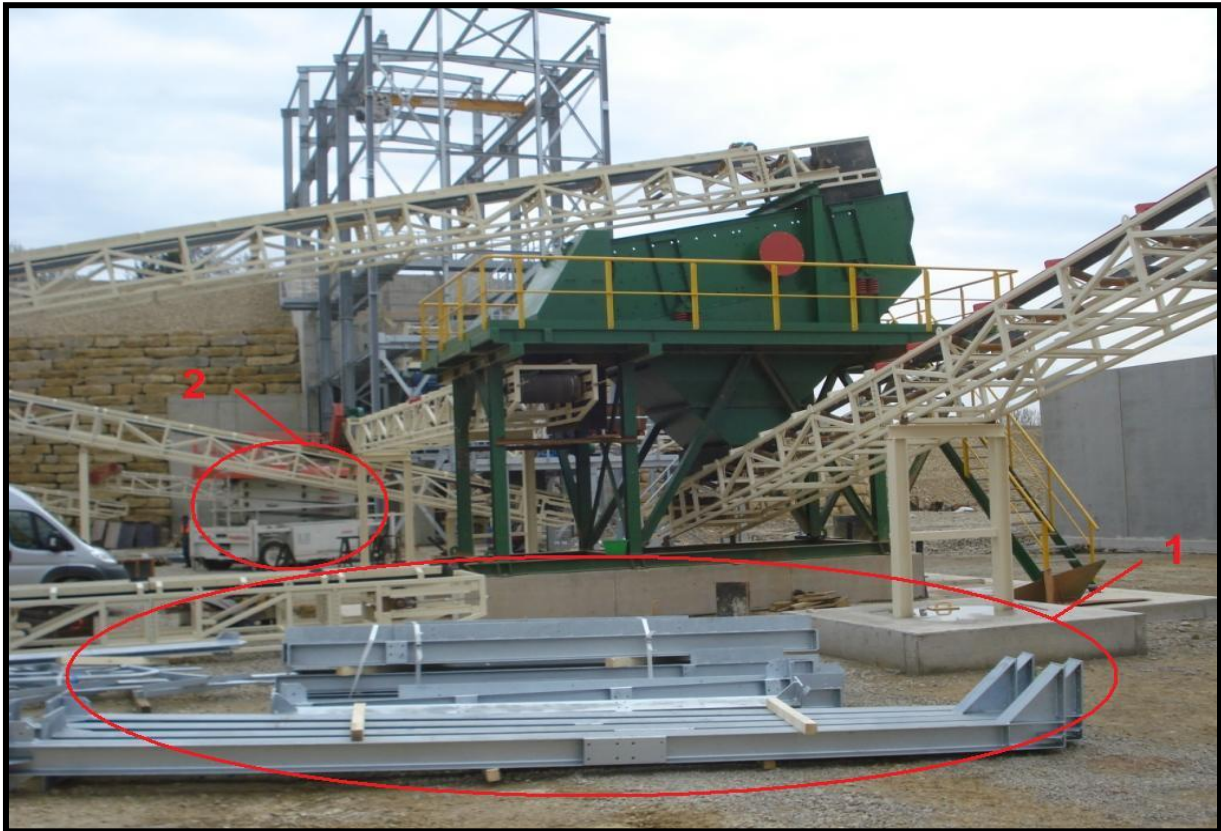
Gelagertes Material und Maschinen auf einer Baustelle
