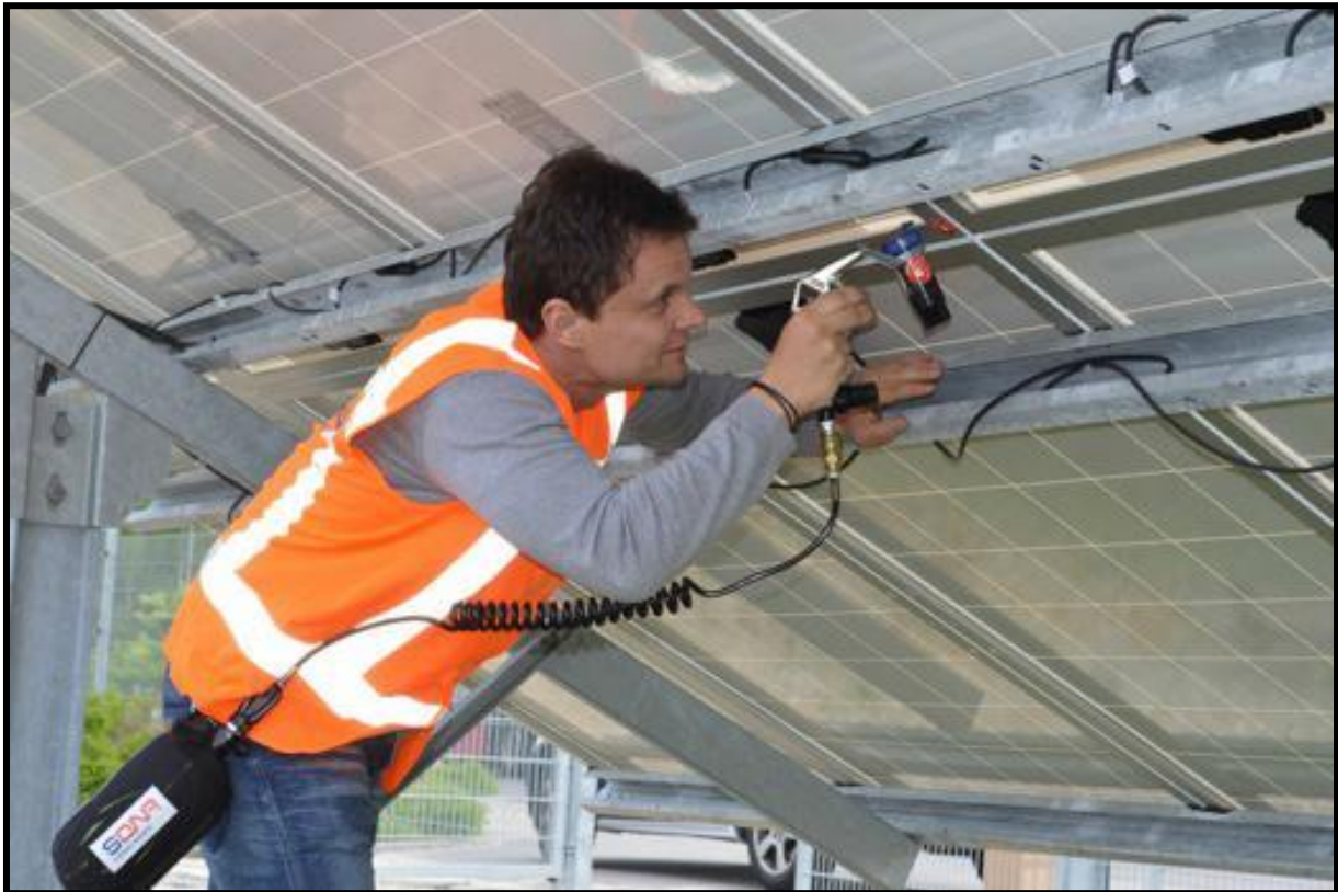
Markierung von Photovoltaikanlagen mittels Sprühpistole
