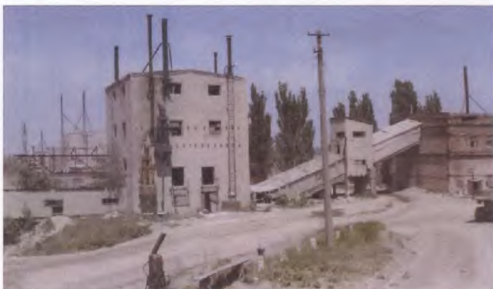
Typische russische massiv gebaute Aufbereitungsanlage mit einer Vielzahl von Zyklonentstaubungen.
