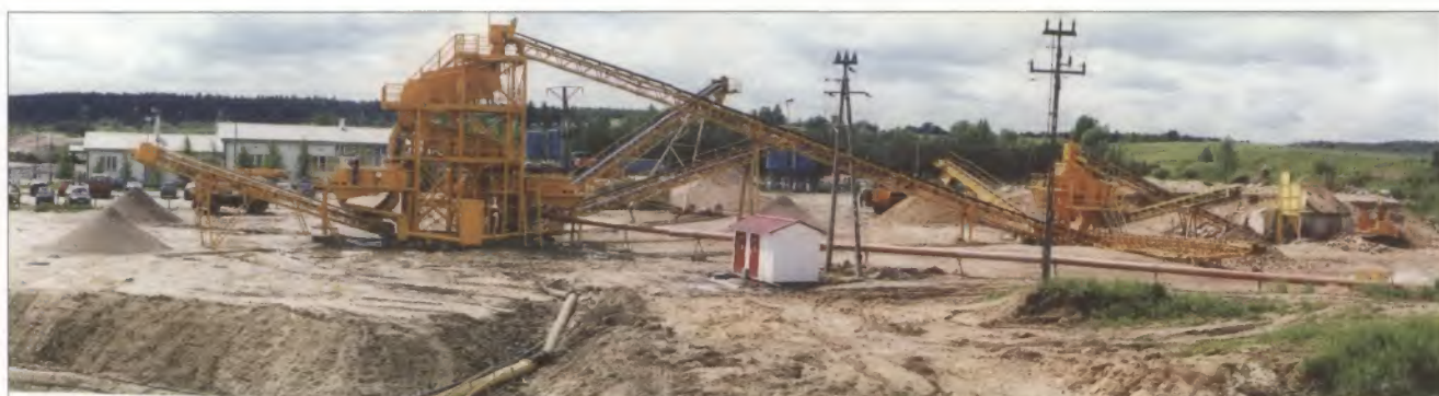
Quasistationäre Aufbereitungsanlage für Sand- und Kies (Foto Verfasser)
