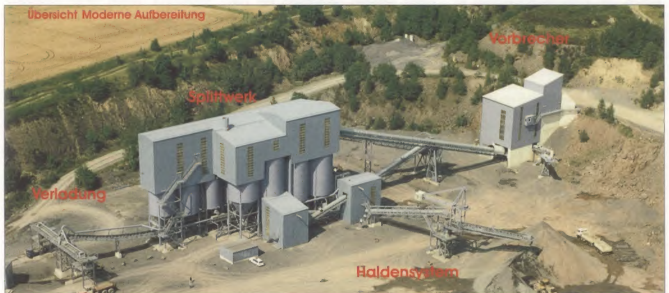
Moderne stationäre Aufbereitungsanlage im Hartgestein (Foto Thomas Seise)
